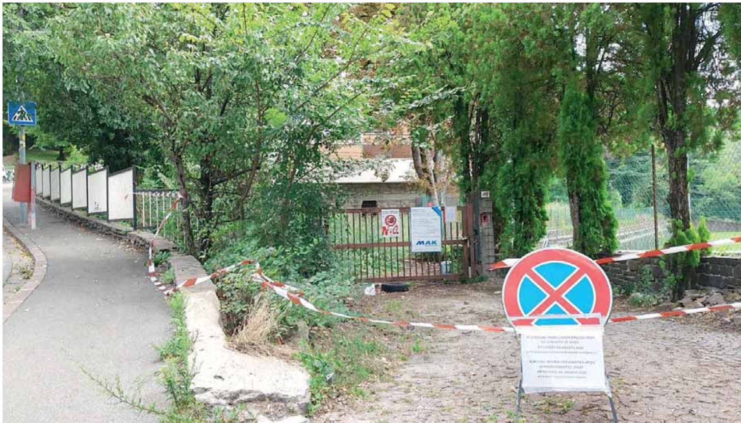
• L'ingresso del cortile dell'ex convitto St. Josef, in via Castel Flavon. L'area, in stato di abbandono dal 2007, ospiterà 65 alloggi Ipes
