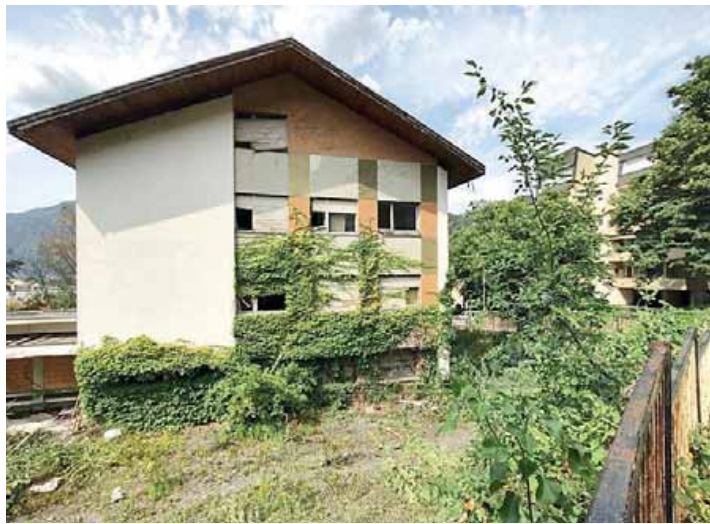
• L'edificio che ospitava il convitto è abbandonato dal 2007
